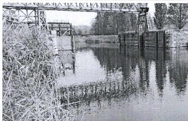
Kanal DTD - kod betonskog mosta
