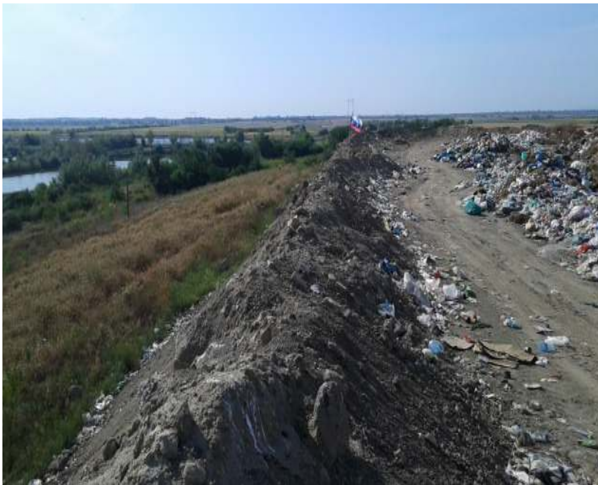
Слика 4.6. Насип који окружује депонију служи као заштита од разношење отпада
