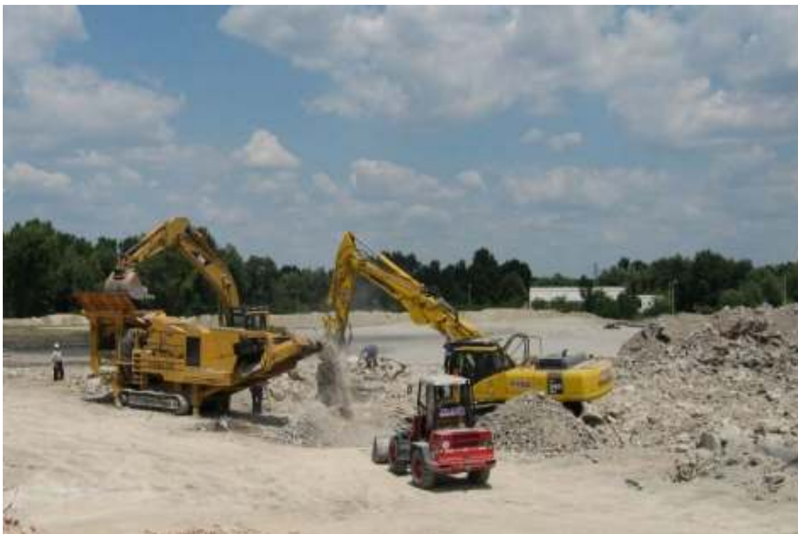
Слика 5.12. Рециклажа грађевинског отпад
