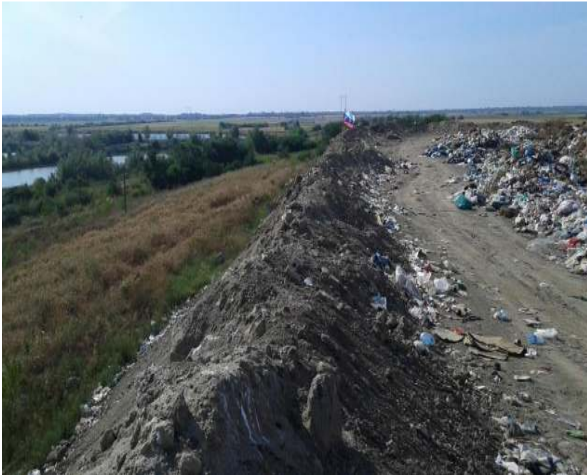
4.6 – os sz. kép: A hulladéklerakót körülvevő töltés védelmet nyújt a hulladék terjedése ellen
