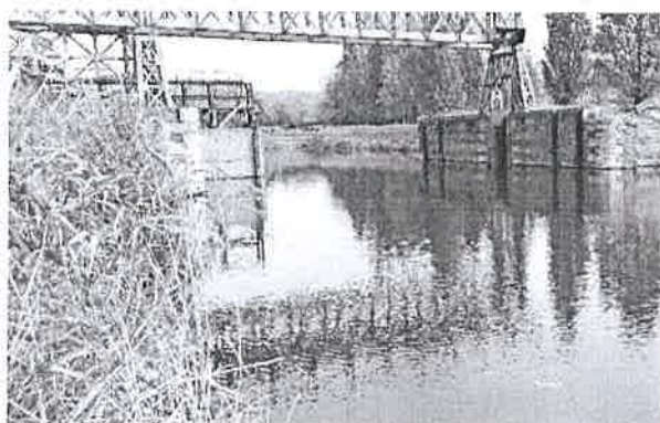
Kanal DTD - kod betonskog mosta
