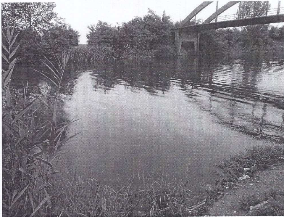
Slika 1. Kod betonskog mosta
