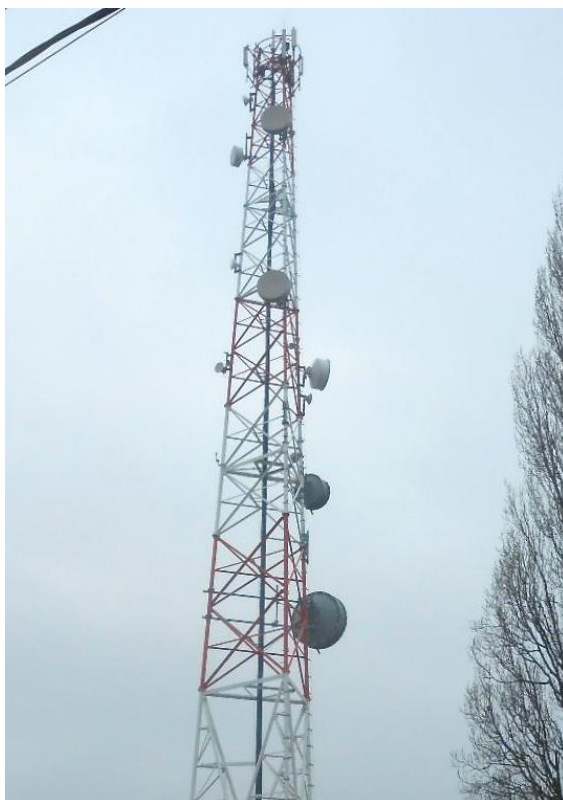
Slika 2. Stub na kome je instaliran antenski sistem
