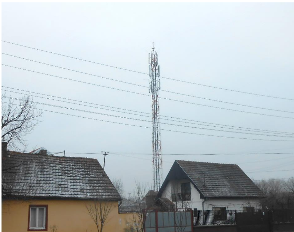
Slika 2. Stub na kome je instaliran antenski sistem
